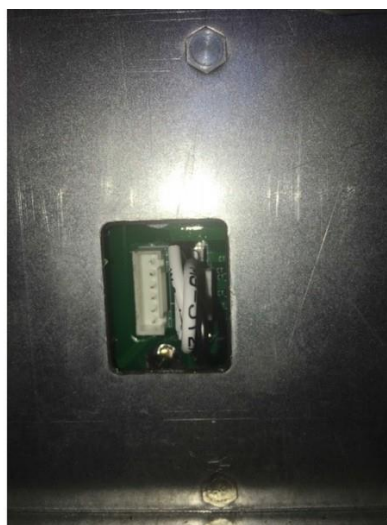
J12-sin módulo colocado DERECHA
